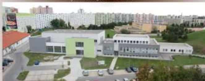
Výstavba auly UCM v Trnave
